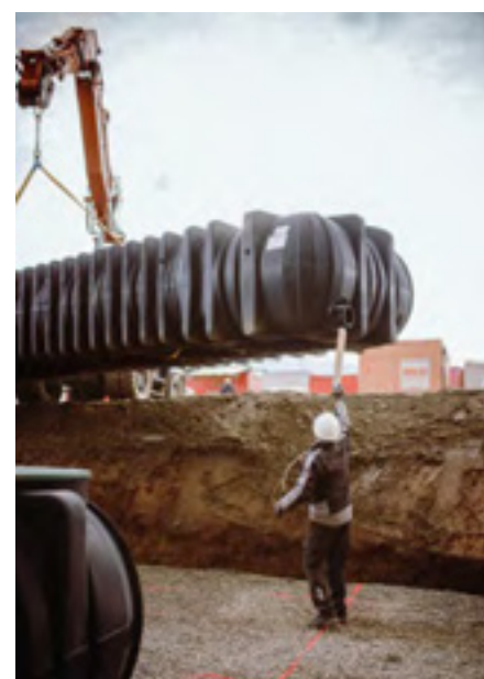
Hauruck! Hier im Bild wird einer der drei GRAF Platin XXL Tanks mit einem Bagger in die vorbereitete Baugrube eingehoben. (Foto: GRAF)
