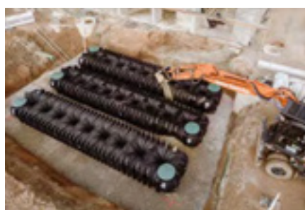
75.000 Liter in Reih und Glied: Da liegen sie, die drei Flachtanks, in einer Tiefe von 2,75 Metern auf einem Bett aus Kies. (Foto: GRAF)
