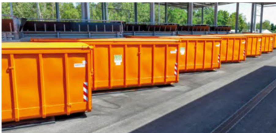
Alle 16 Container sind heute überdacht, damit durch das Regenwasser keine Auswaschung von Abfallschadstoffen stattfindet. Die Rinnensystemlösung BIRCOpur® ermöglicht die umweltschonende Wasserbehandlung, -verteilung und -versickerung vor Ort.
