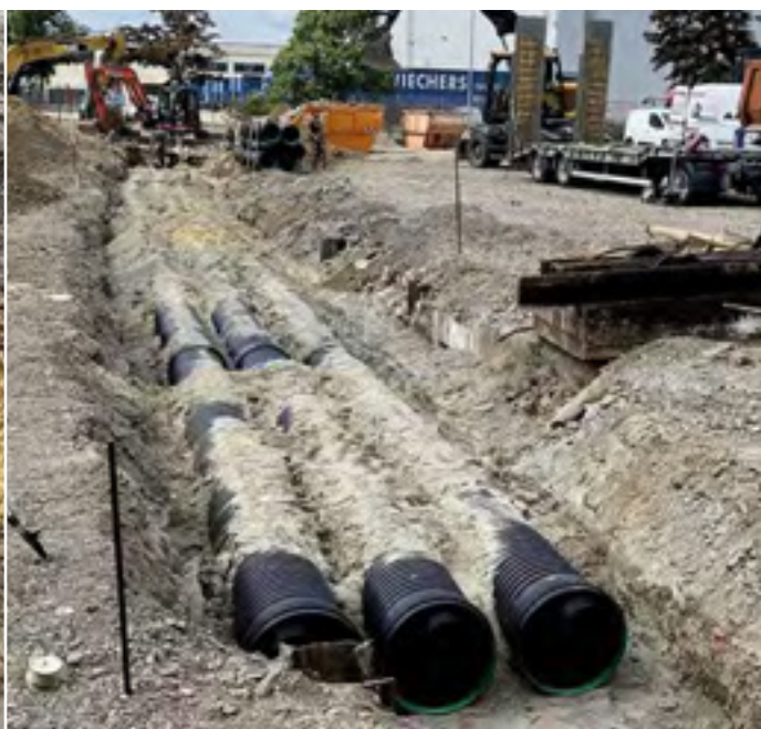
Baumaßnahme mit dem Stauraumkanal 3x AQUATUB-Rw DN 800
