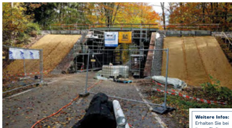
Oberflächenerosionsschutz nach Fertigstellung (unbegrünt)
