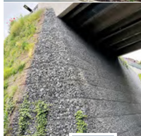
Einsetzende Begrünung der fertigen Böschung / Gabionen- optik unter der Brücke
